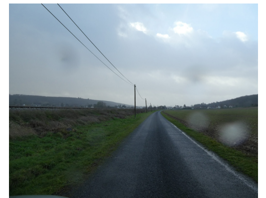
Route communale et voie ferrée installée sur merlon
