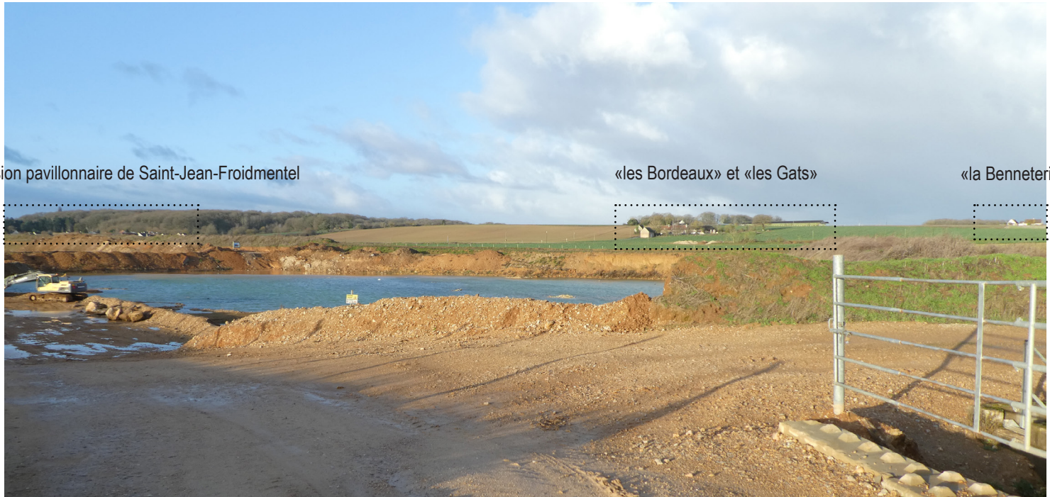
⑥ Zone de l'ancienne carrière devant être remblayée Lieu : Depuis la partie centrale du site
